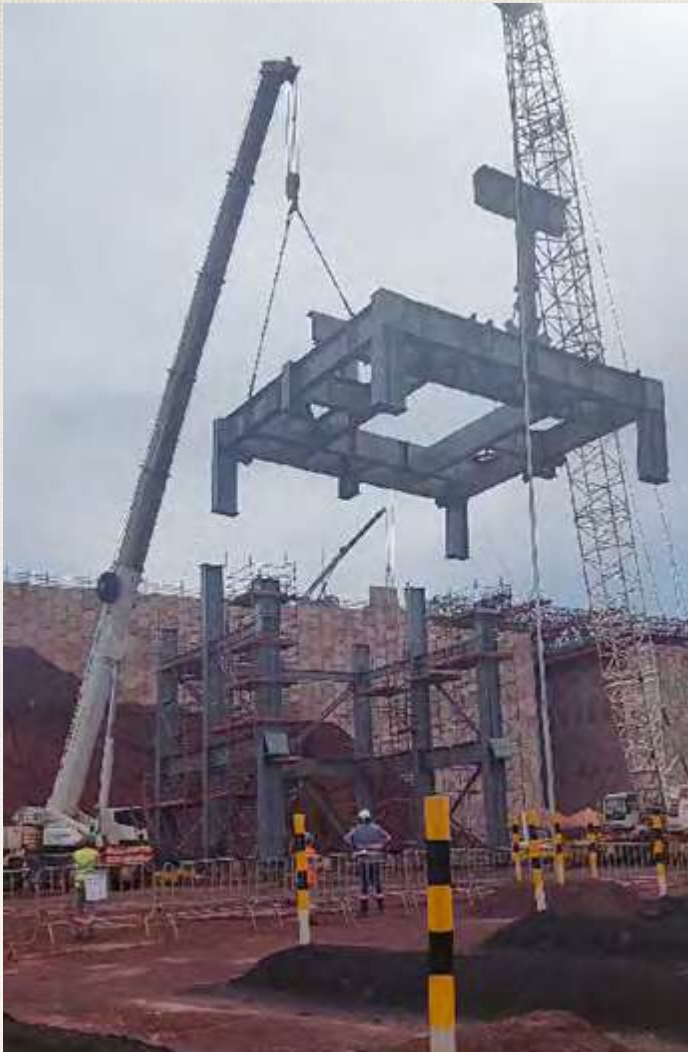
Estrutura da moega içada a 16 m de altura
