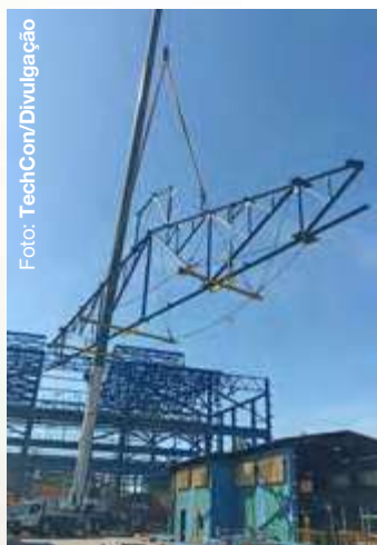
Içamento de treliça para posicionamento entre os módulos
