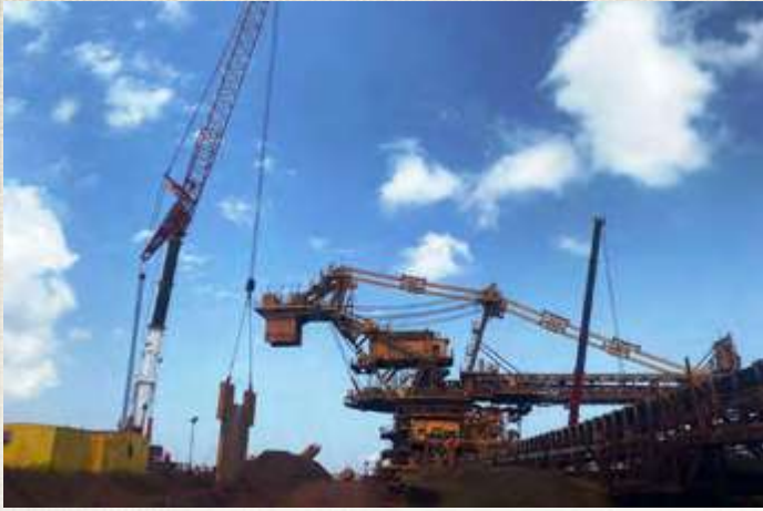
Disposição em vala de contrapeso da recuperadora
