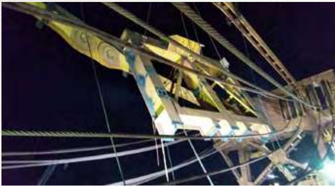
Retirada da cobertura do antigo eletrocentro entre cabos de aço
