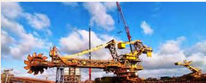
Içamento e montagem do novo módulo 3 do eletrocentro superior
