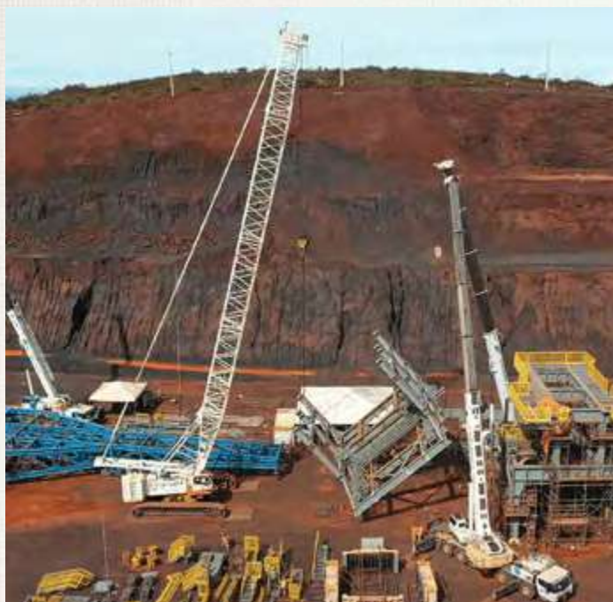
Movimentação de peça da estrutura de britagem semi-móvel
