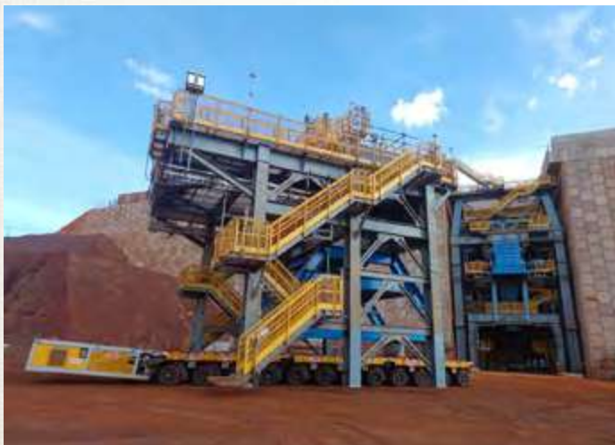
Chegada do britador semi-móvel
