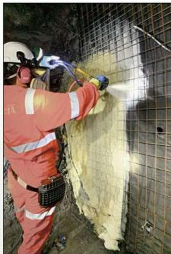
**Base da parede com tela de aço e metalon, tela bematel e manta bidim**
