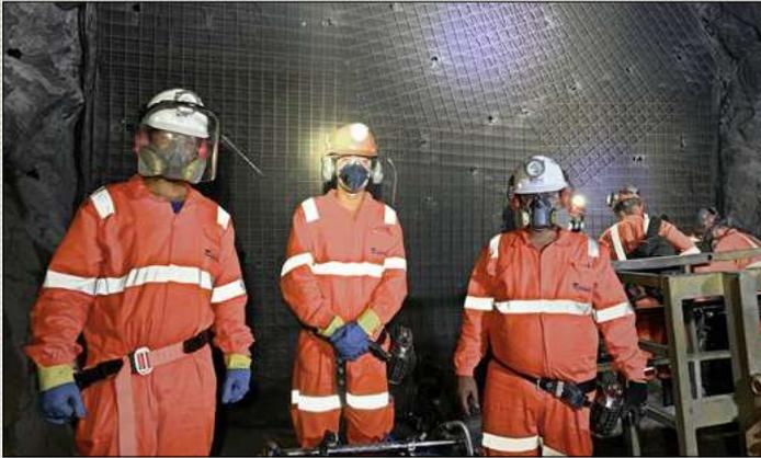
é feita in loco, dentro da mina. A construção começa com a instalação de uma tela de aço e metalon, sobre a qual são colocadas uma tela bematel e uma manta bidim. Com essa estrutura pronta é aplicado o silicato de cálcio com um projetor específico usado para silicato ou poliuretano. O produto se expande e se fixa na parede, vedando-a integralmente.
